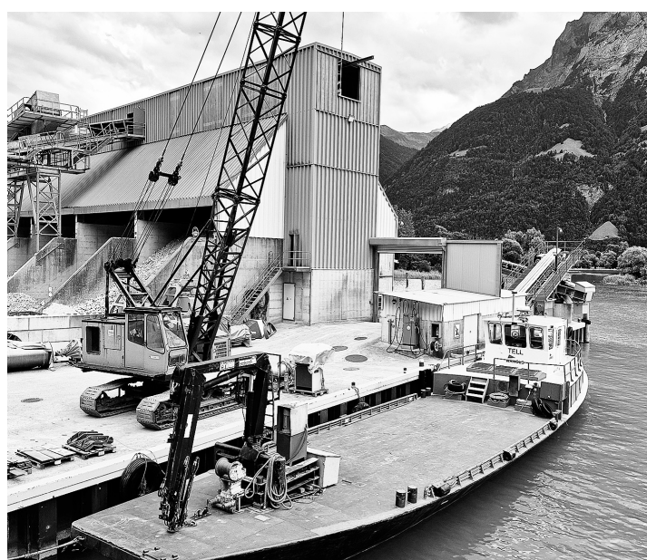
Verladestation in Flüelen: Neue Flachwasserzonen bis 2030
